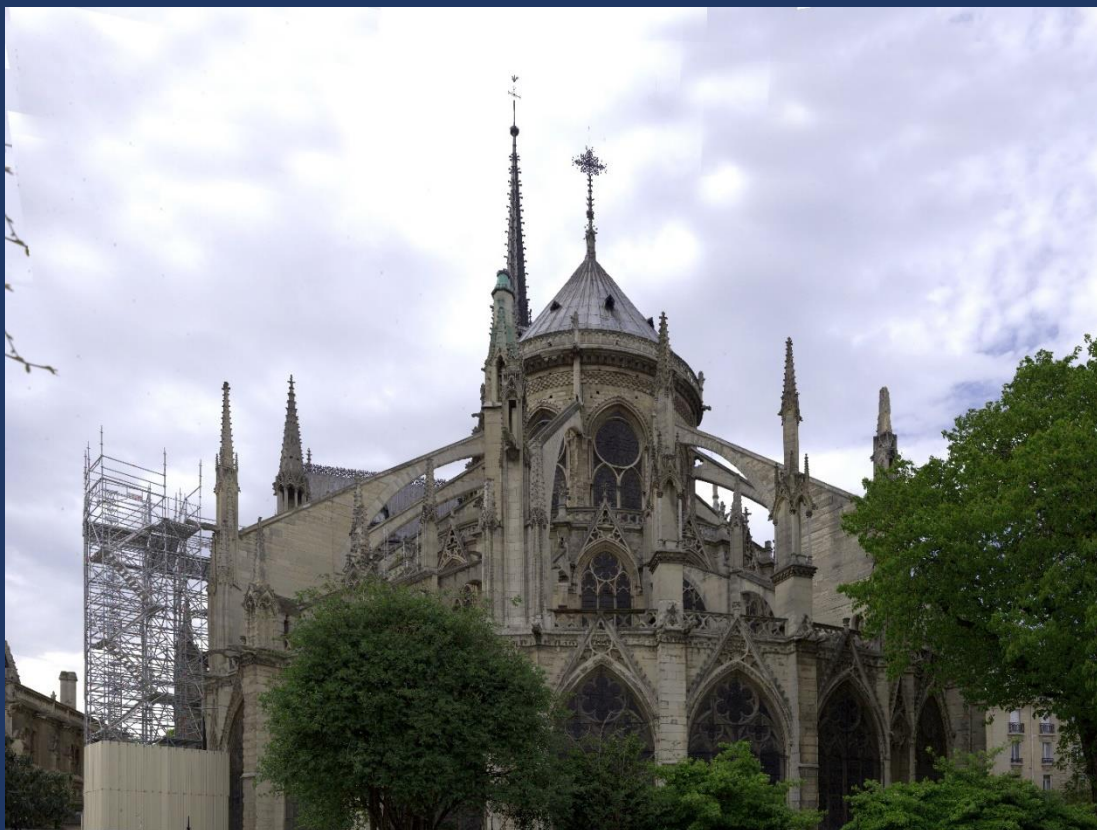
L'échafaudage s'installe et grimpe autour des contreforts devant le chœur de la façade sud, le 08 avril 2018.
