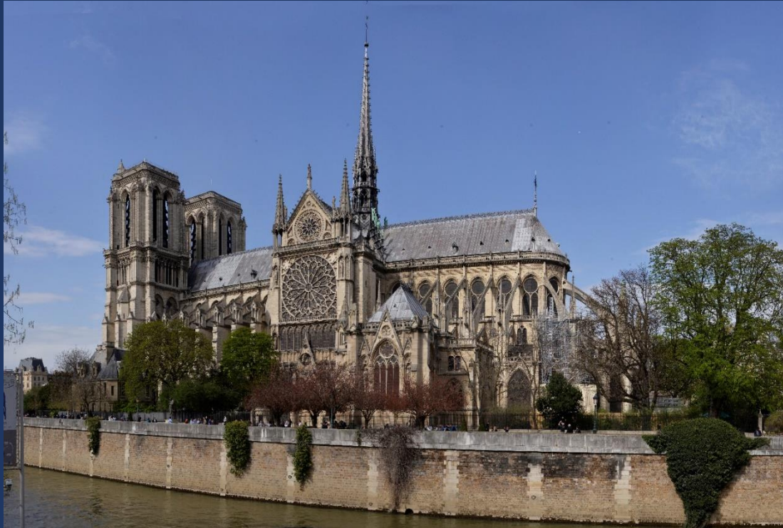
Voici le début des travaux à droite devant le chœur.
